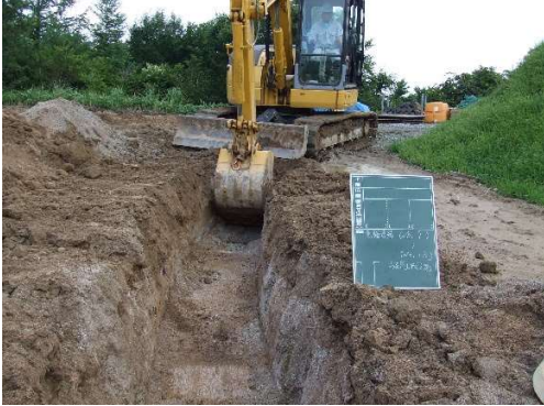
写真1. 重機による掘削
