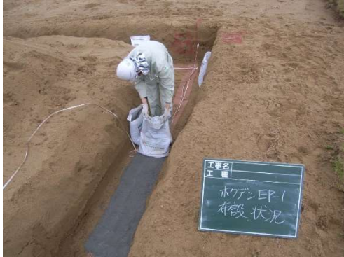
ホクデンEP-1敷設
