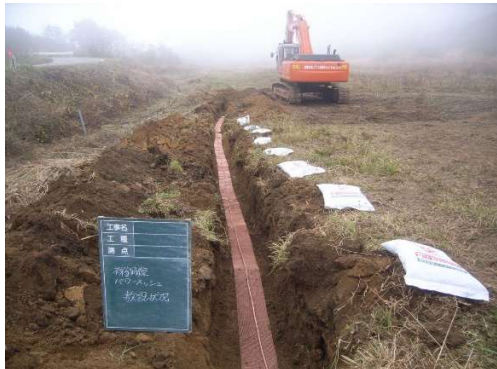
裸銅線の敷設
