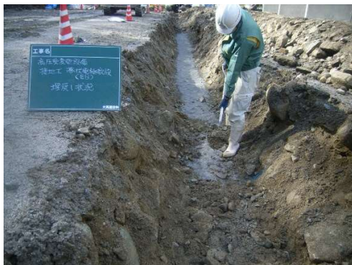
人力による埋め戻し
