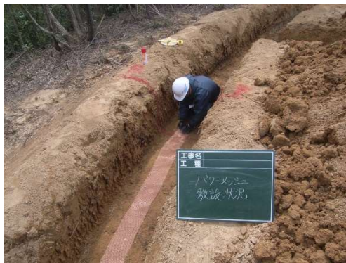
写真2. 溝の底面を平らにならす
